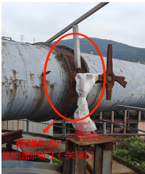
图6 有内漏现象的蝶阀
