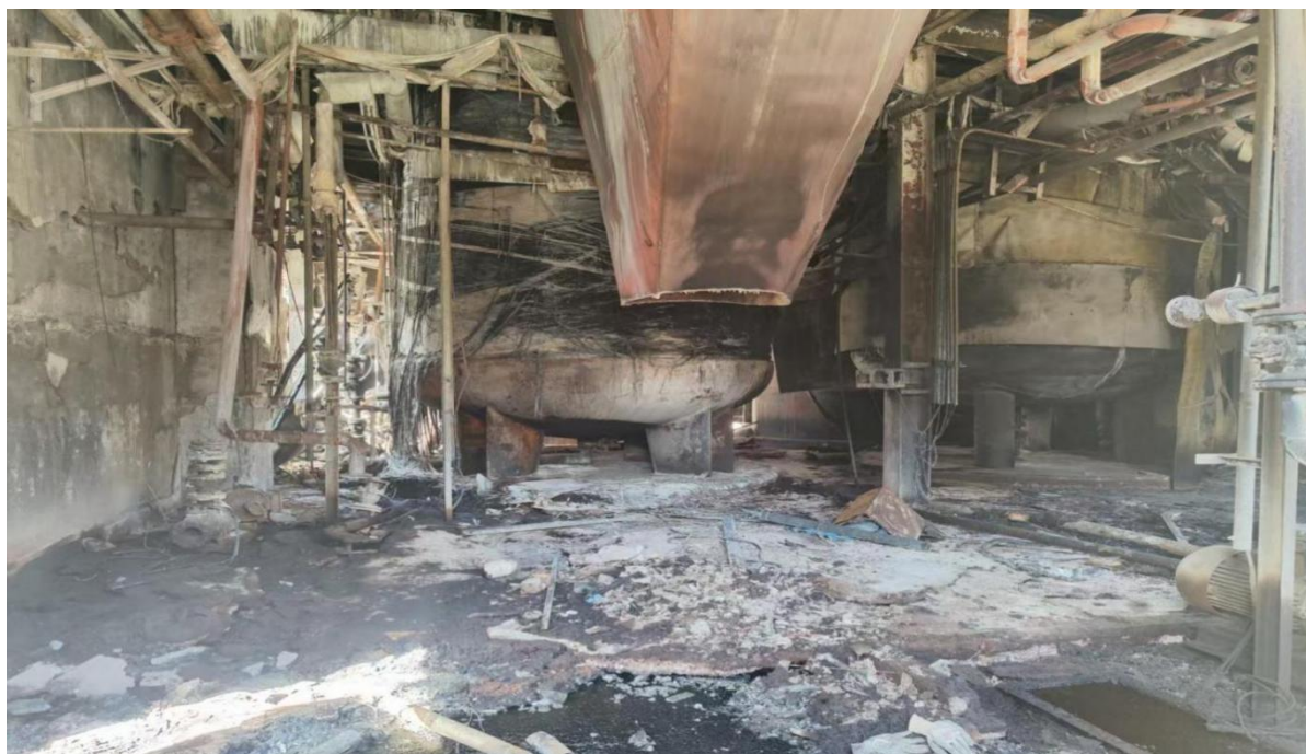
图 4 PPH 材质中转储罐
