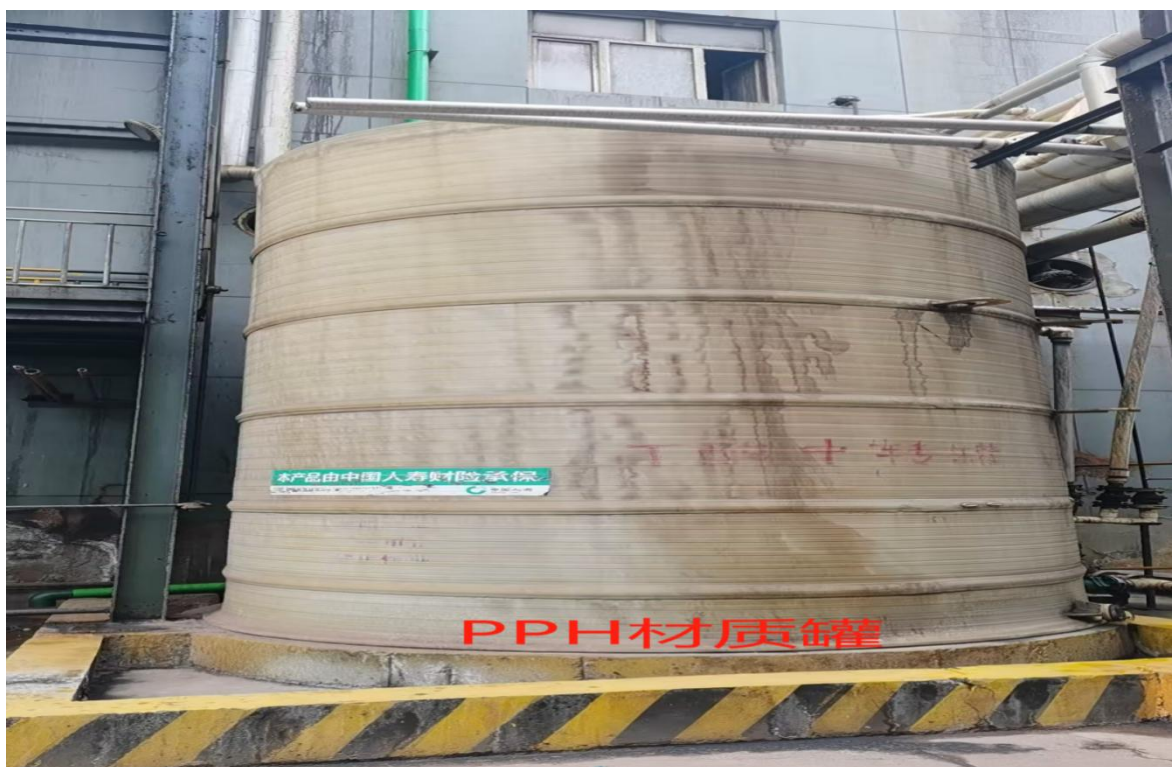
图 4 PPH 材质中转储罐
