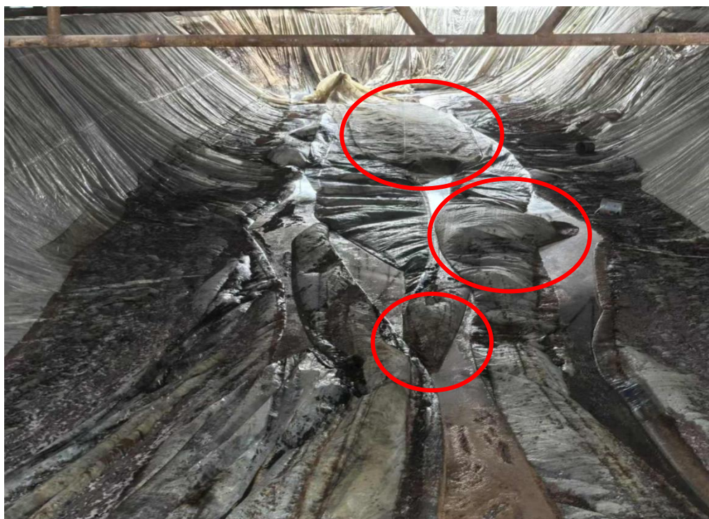
图7 浆池覆膜编织布夹层鼓包图
