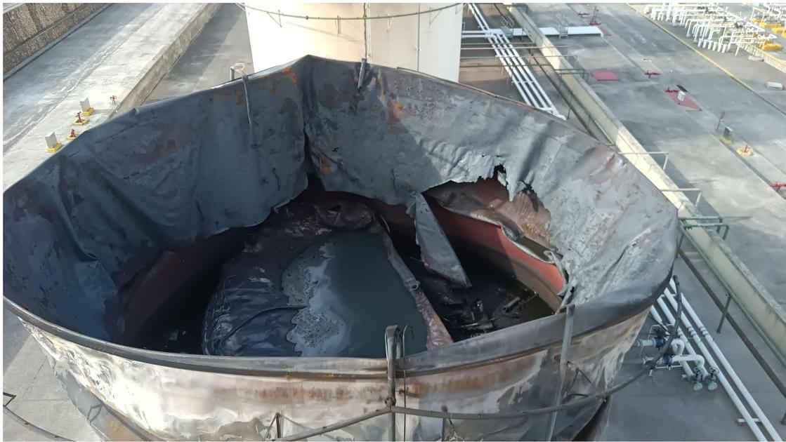
图 3 贵定宝塔石化火灾事件后 4#罐现场图
