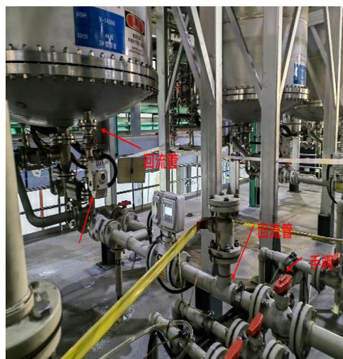
图 9 提浓机与反应釜连接的回流管
