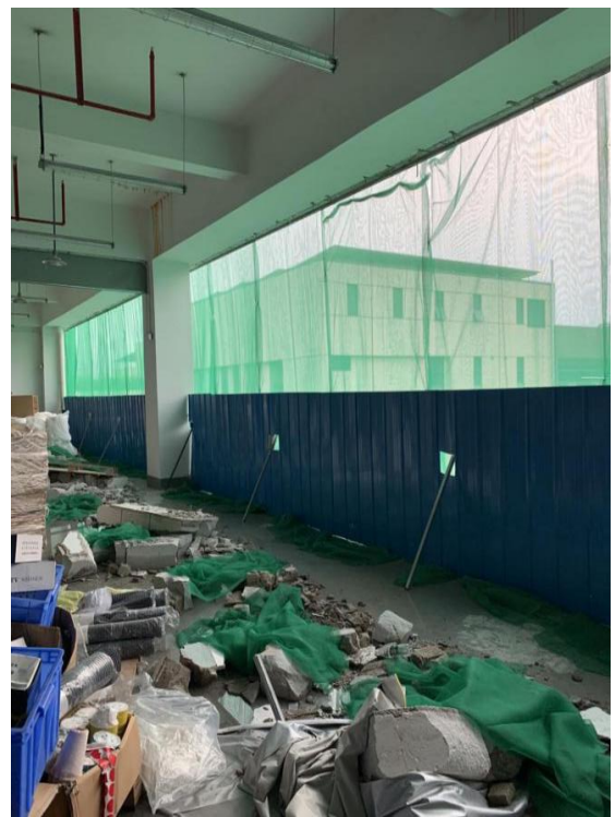
(图 5, 顶棚有明显燃烧积碳痕迹)
