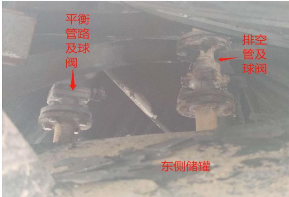
图 7 戊烷储罐排空阀未打开
