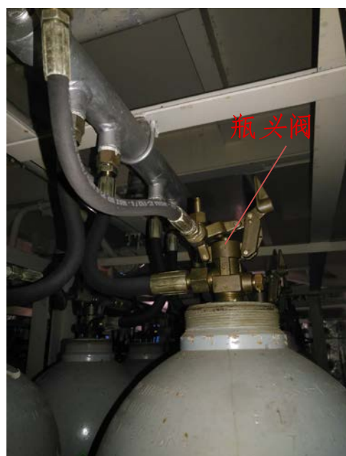
图 2 瓶头阀（采自气瓶间）
