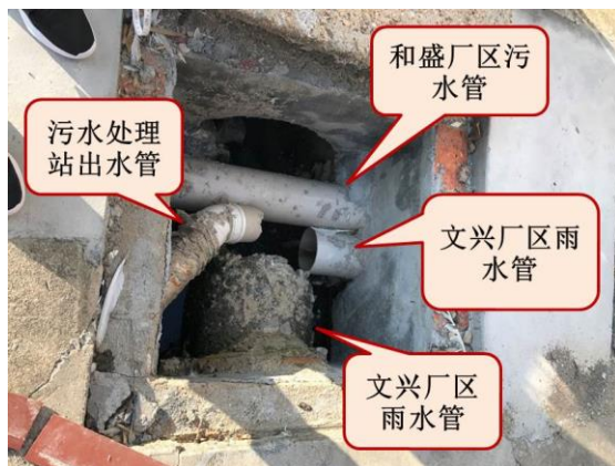
图 5 调节池东北侧雨水井内管线分布
