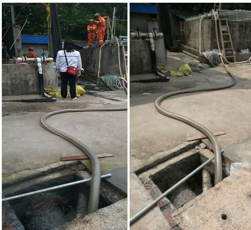
图 6 事故救援现场排水管放置方式
