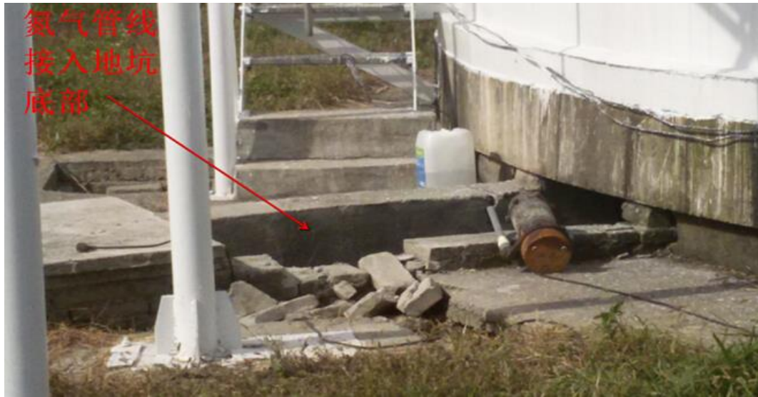
液氧储罐底部地坑
