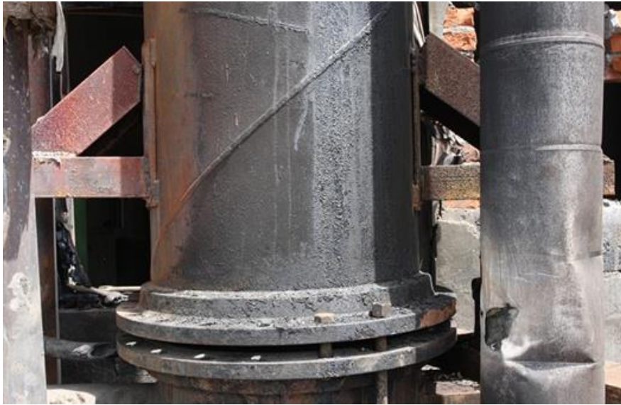
图 1 煤气管道装盲板处
