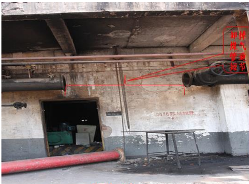
图 2 煤气管道清扫作业处
