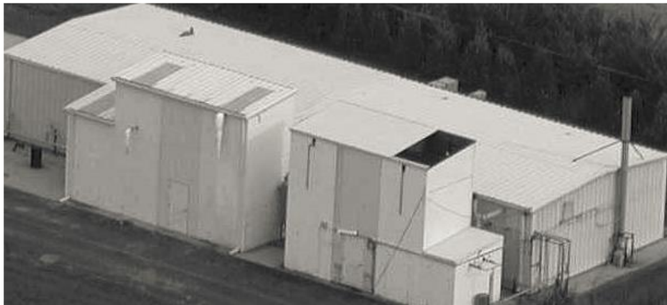
图 4：N6 单元的外部爆炸防护建筑（与 N3 单元相似）
