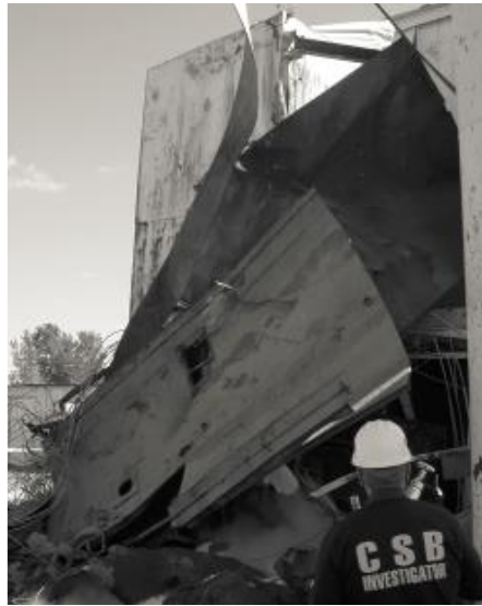
图 8：爆炸防护建筑受损严重
