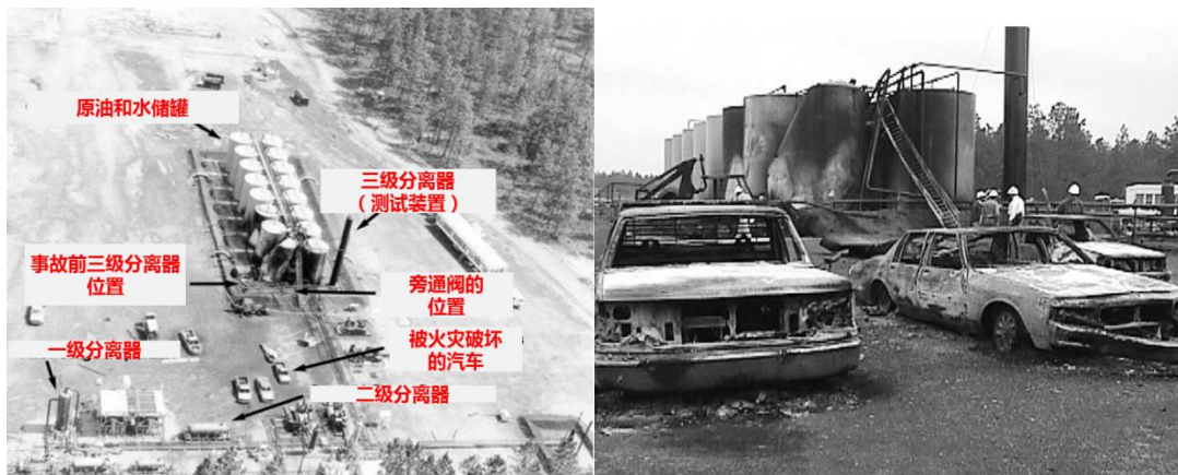
图 1：事故后现场照片
